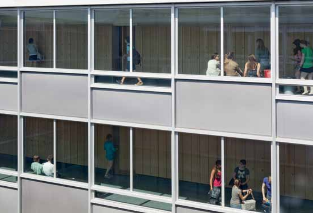
An der Kantonsschule Rychenberg liefern knapp 6200 Quadratmeter Glas Ein-, Durch- und auch einmal Ausblicke.
